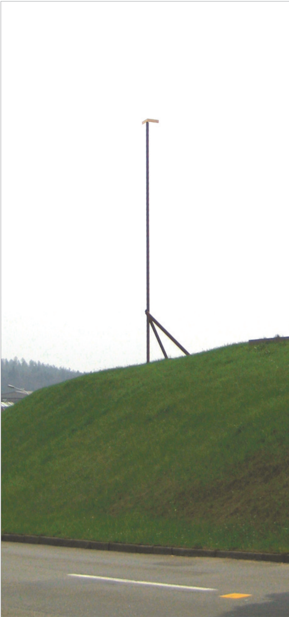
Eisenrohre Betonfundamente Winkel auf Walzenlager Höhe 12 m
