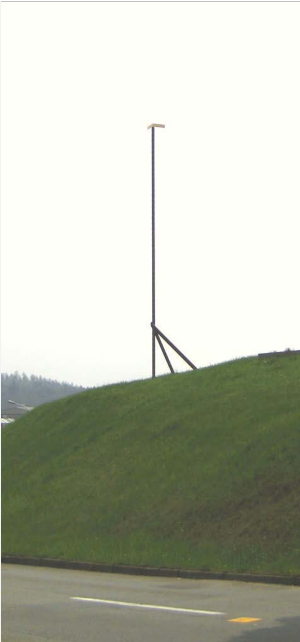
Eisenrohre Betonfundamente Winkel auf Walzenlager Höhe 12 m
